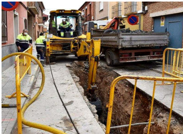
Una obra de renovación de redes de agua, en imagen de archivo. / LT
