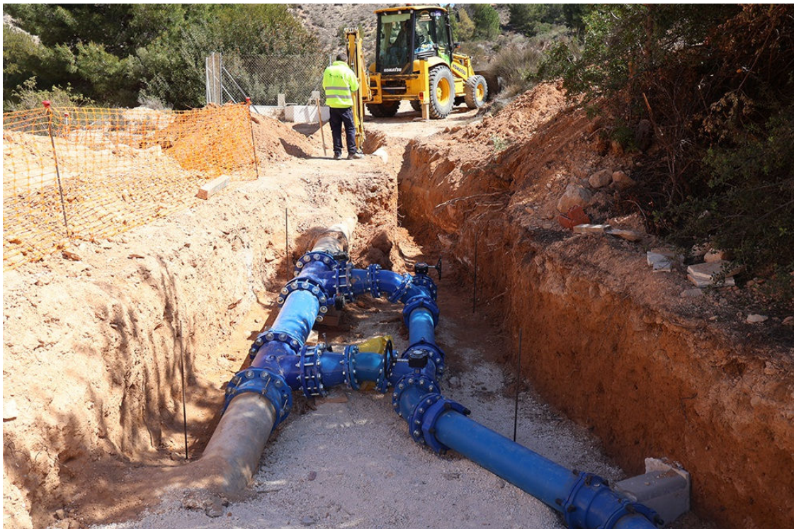
Obras que se ejecutan en Novelda. | Ayuntamiento de Novelda
